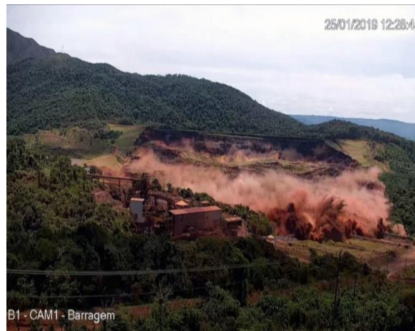
No detalhe: Momento do rompimento da Barragem B1 em Brumadinho 2019. Fonte G1.com
